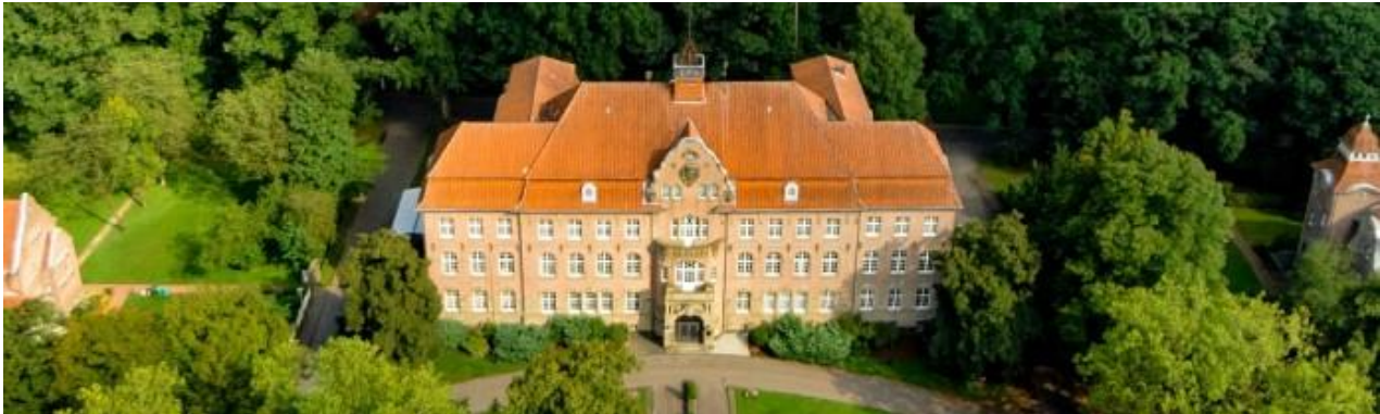
Haupteingang zur Hauptverwaltung der LVR-Klinik Bedburg-Hau
